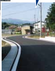
エヌエスコサンド® 入り アスファルト舗装
